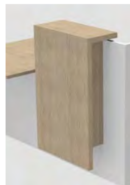
Parement installé avec entretoise
